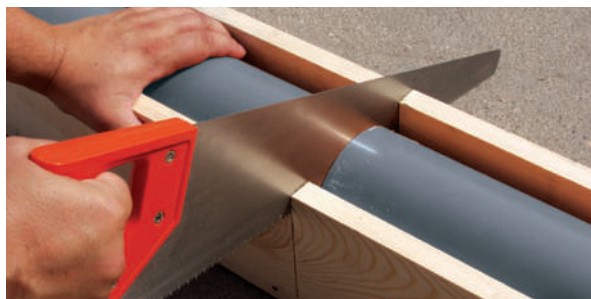
Рисунок 2 Скос дополнительно сокращенной трубы
